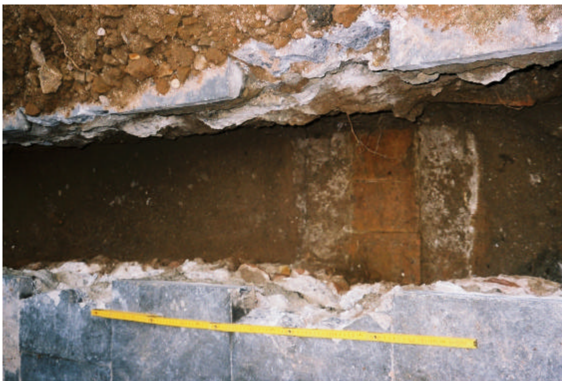
Foto. 8. Solera de claveguera U.E: 110.
