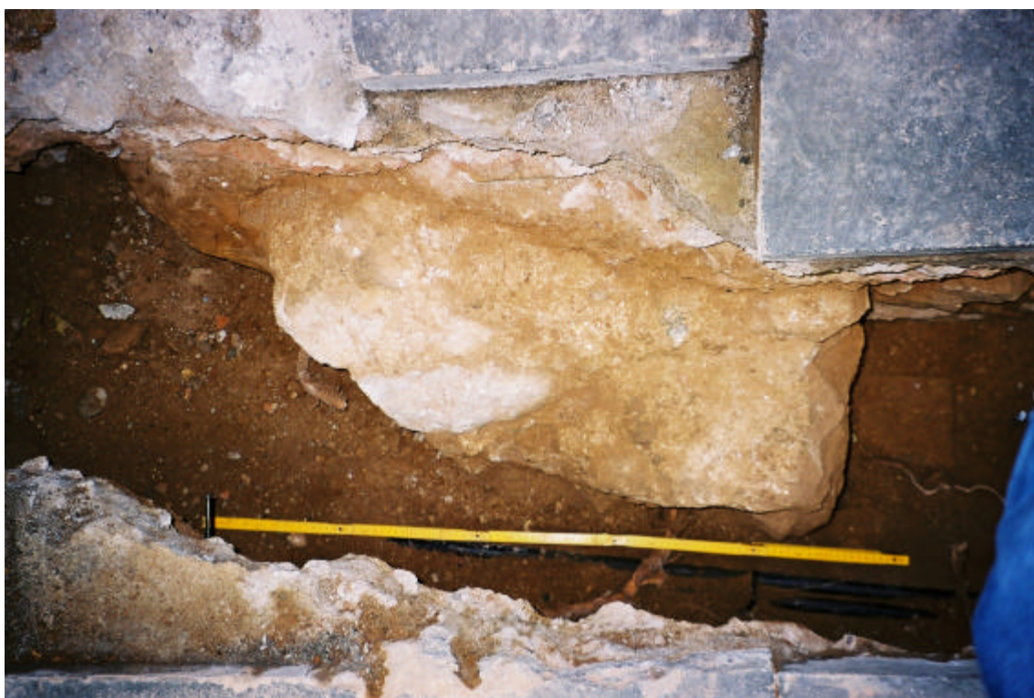
Foto. 6. Mur U.E: 107. També s'aprecia l'U.E: 104 la qual talla el mur i s'hi pot veure que hi ha runa, pedres i totxos.
